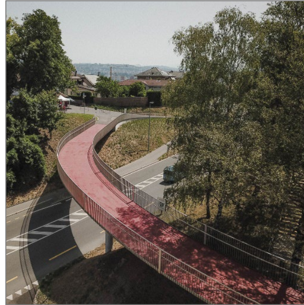
Route de la Pierre, Ecublens footbridge
