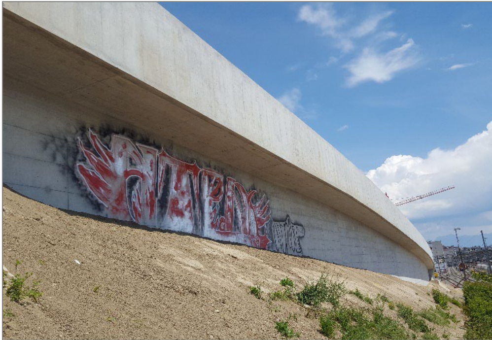
Liaison Ouest, Plateforme 10, Lausanne retaining wall
